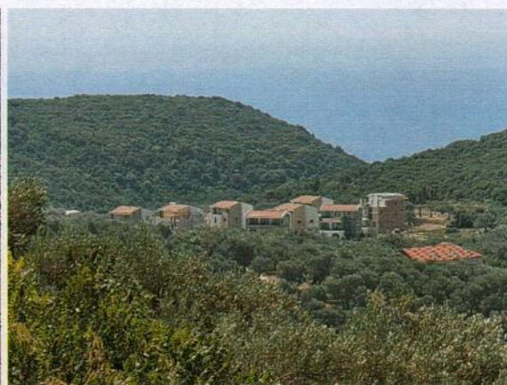
Višespratni objekti, izgrađeni i u izgradnji
