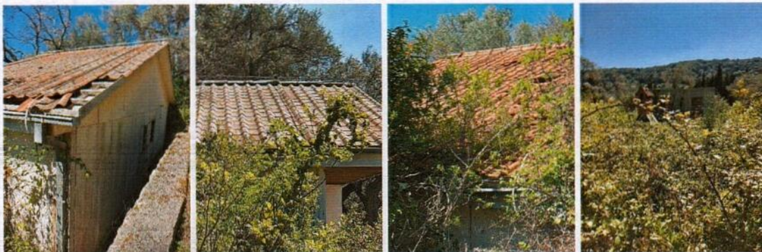
Azbestni krovni pokrivač, vrlo rijetko ravne tige/crijep i još rjeđe dimnjak u maslinadi, 08.04.2026.
