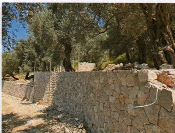
Radovi na podzidama
