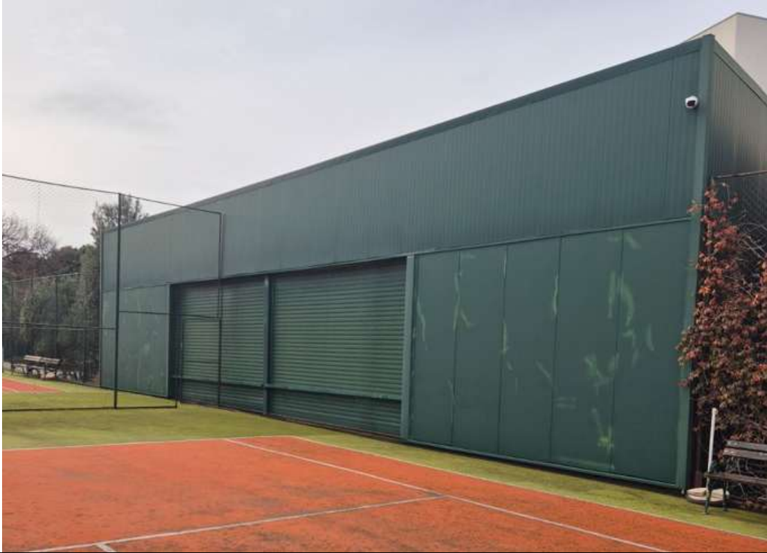
Istočna fasada objekta hale
