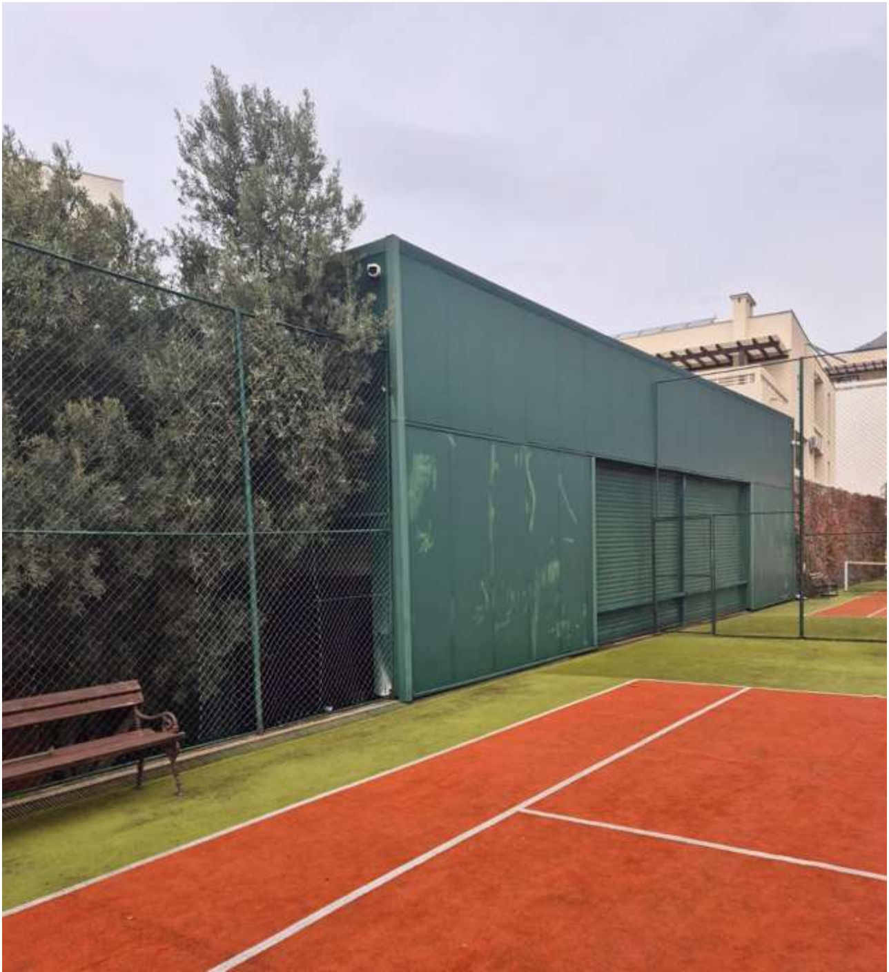
Jugoistočna fasada objekta hale na dijelu kp 3222/1 KO Pečurice, Bar
