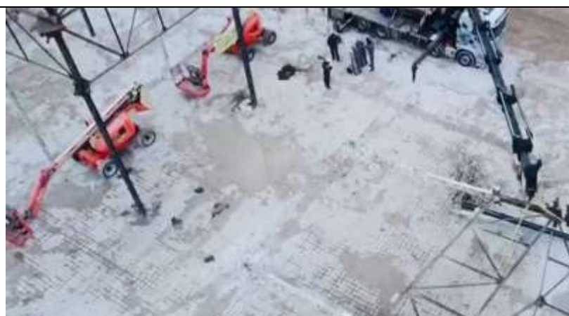
Primjer demontaže( fiksiranje elementa na dizalicu, oslobađanje od veza rezanjem, spuštanje dizalicom na tlo I odlaganje)
