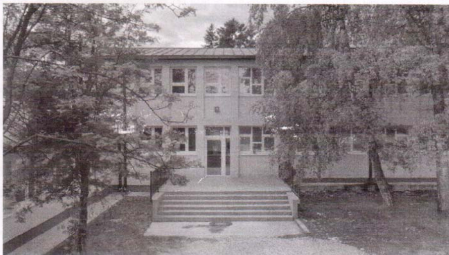
Sporedni ulaz u objekat – Ulaz br. 3
