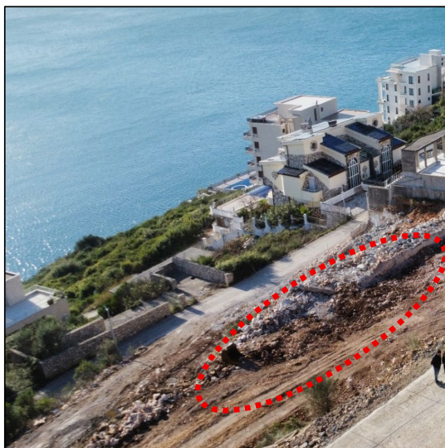
Dron snimak lokacije – mjesto nekadašnjeg objekta na UP
