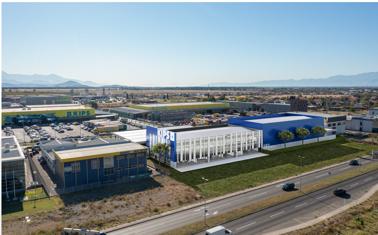
Slika 3 / Prostorni prikaz objekta sa okolinom
