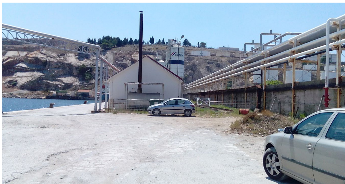
Sl.7 Predmetna lokacija (7.5) za postavljanje silosa za cement
