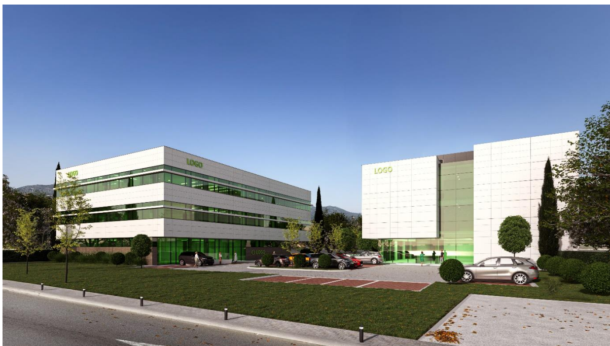
ULAZNA FASADA OBJEKTA
