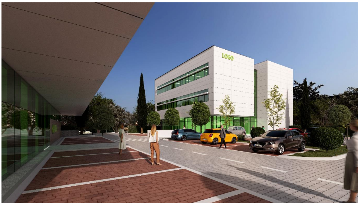
ULAZNA FASADA OBJEKTA
