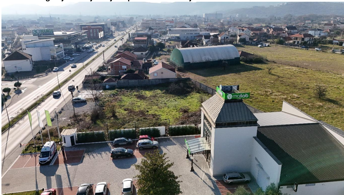
slika 3 : fotografije lokacije- objekti planirani za rušenje
