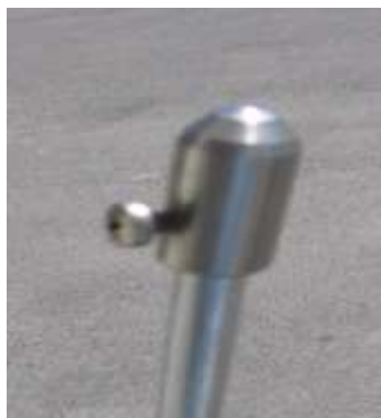
Slika 3: Izgled špica LOV montiranog na vodič AH-2
