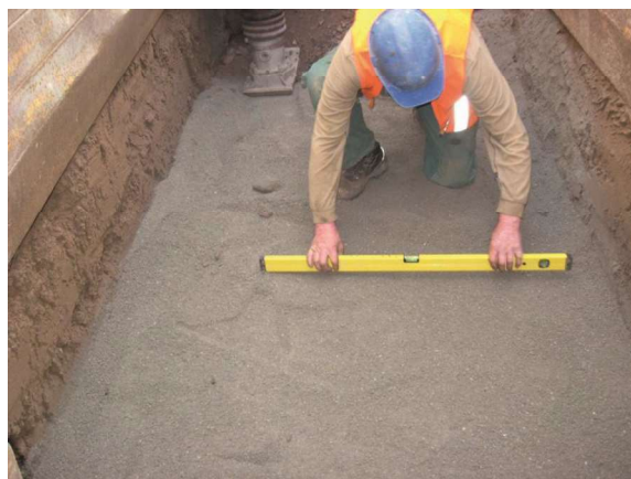
Slika 1 i 2: Priprema podloge za polaganje šahtova
