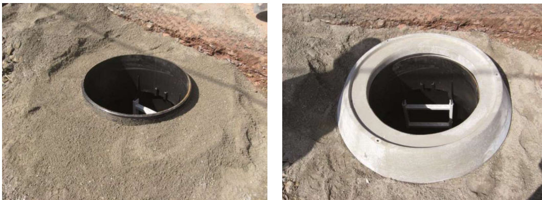
Slika 9 i 10: Postavljanje betonskog prstena za prihvatanje opterećenja
