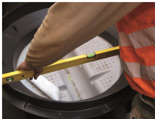
Slika 3 i 4: Kontrola položaja odvoda
