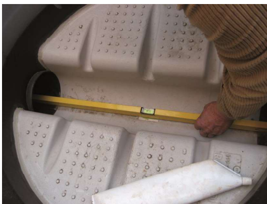
Slika 3 i 4: Kontrola položaja odvoda
