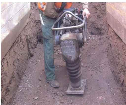
Slika 1 i 2: Priprema podloge za polaganje šahtova
